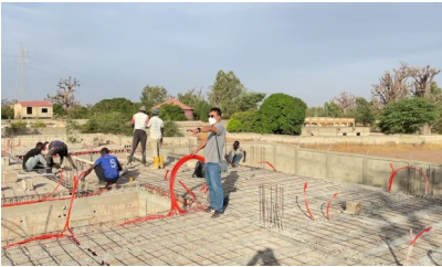
< 옥상 콘크리트 타설 준비 >
