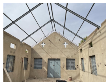
<중단된 예배당 건축 현장>
